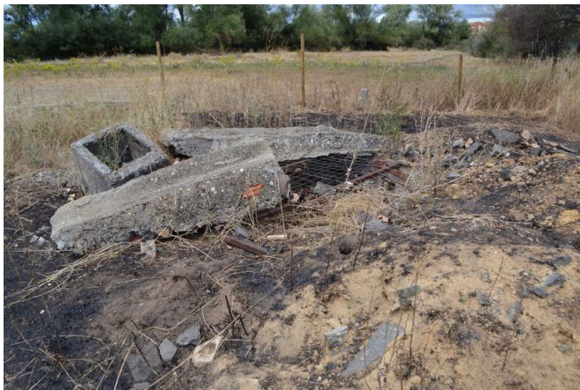
Fotografía del estado actual del pozo de captación de aguas subterráneas.
