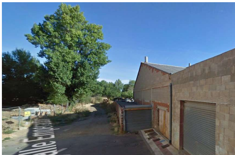
Vista de las construcciones existentes en calle Emperador. Fuente: Goolzoom
